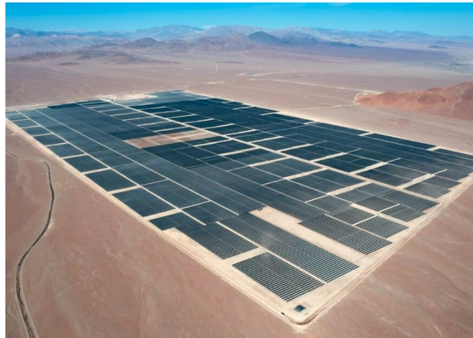
Oasis de Atacama, Chile — solar 272 MW + BESS 1.1 GWh · Greenergy
