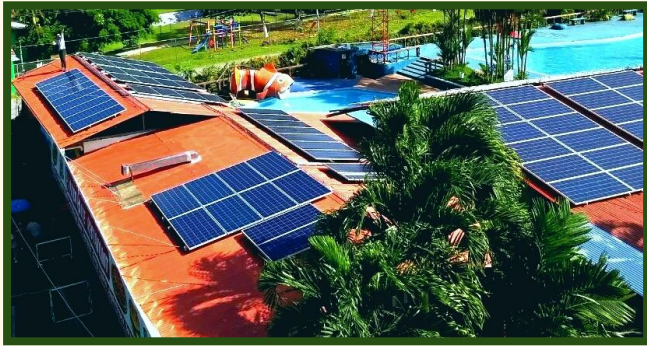
Figura 3: Ejemplo de un sistema de paneles solares
