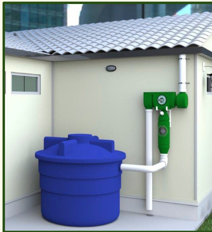
Figura 3: Sistema de recolección de agua de lluvia
