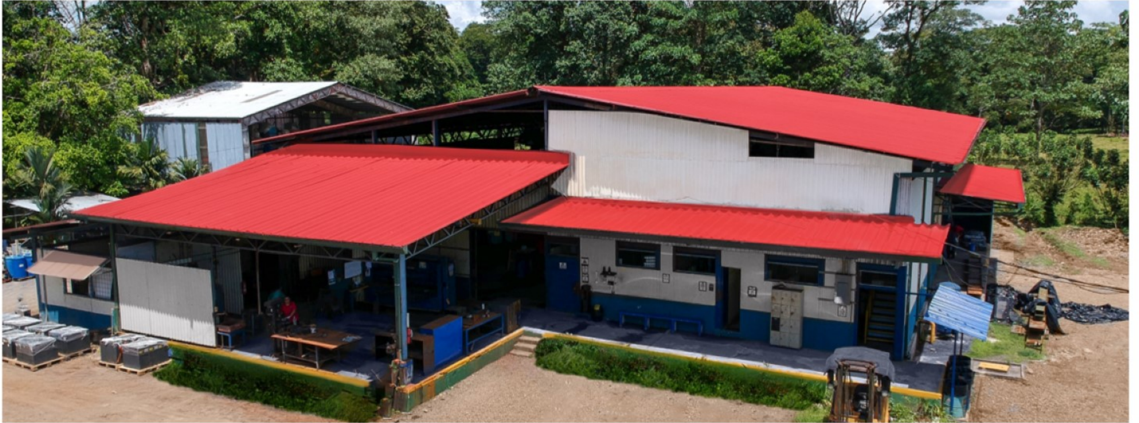
Planta Fabricación de Baterías de Industriales
