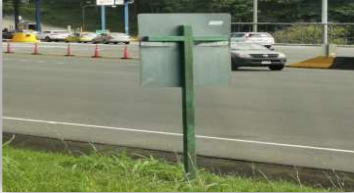
Postes de señalización con polímeros
