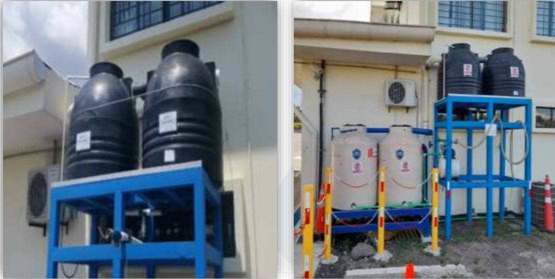
Instalación de tanques para la captación de agua llovida
