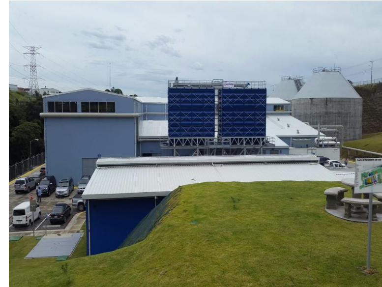
Construcción de Planta de Tratamiento de Aguas Residuales en San José 1/5 parte de la población nacional beneficiada
